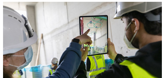
Direkte Überlagerung der Planungsmodelle mit dem realen Gebäude (Gamma AR)
